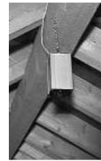
Abb. 3b: horizontale... ... Aufhängung v. D1 mit patent. Kettchen
